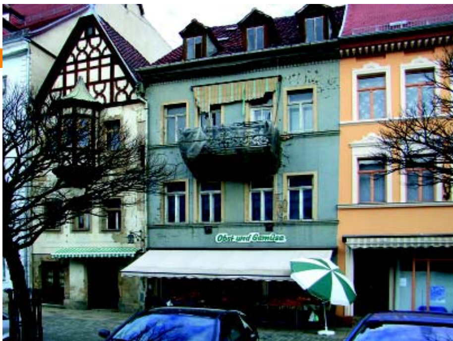
Vorderansicht vor der Sanierung.
