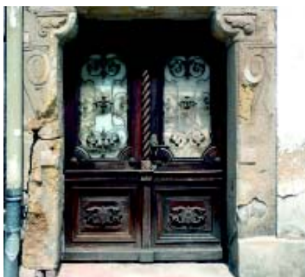
Die historische Eingangstür vor und nach der Sanierung.
