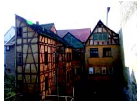
Die Hofansicht des Gebäudes vor und nach der Sanierung.
