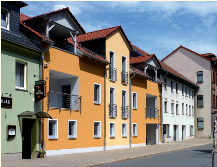
Im Frühjahr dieses Jahres konnten die Mieter ihr neues Domizil beziehen: den Neubau Ernst-Thälmann-Straße 26, ein Schmuckstück im Stadtzentrum.
