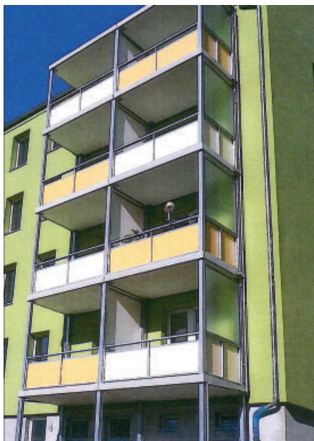
So wird das Haus nach Abschluss der Balkonmontage aussehen.
