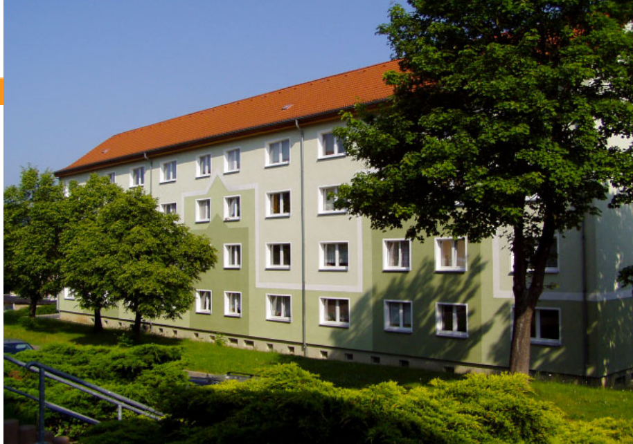
Straße des Friedens 8–12: Anbau neuer Balkone.
