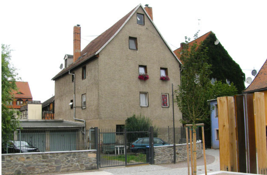
Neugasse 2: Erster Schritt – umfassende Sicherungsmaßnahmen
