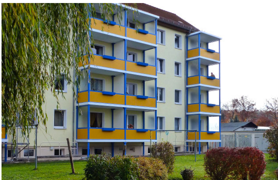
Leonhard-Frank-Straße 10–13: Neue Hauseingangstüren
