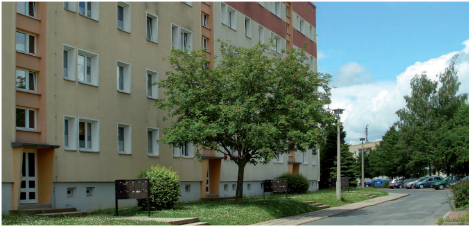
Rückbauobjekt in der Florian-Geyer-Straße
